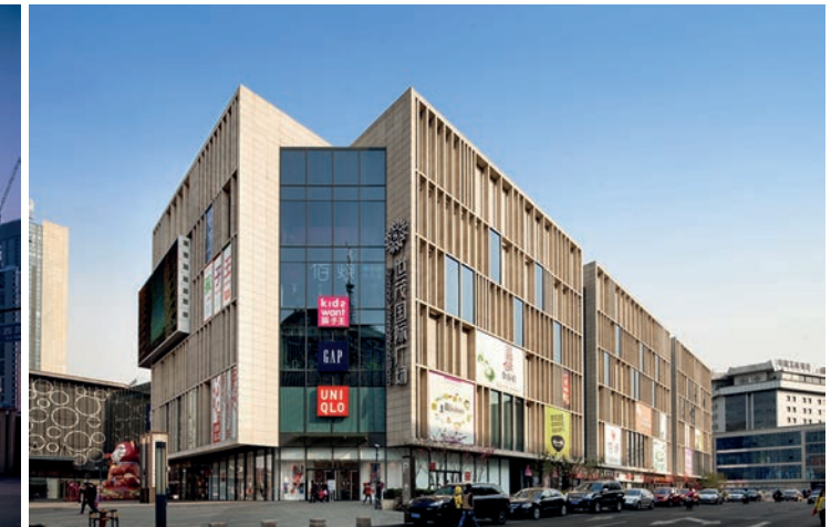
济南·世茂国际广场 Jinan - Shimao International Plaza
